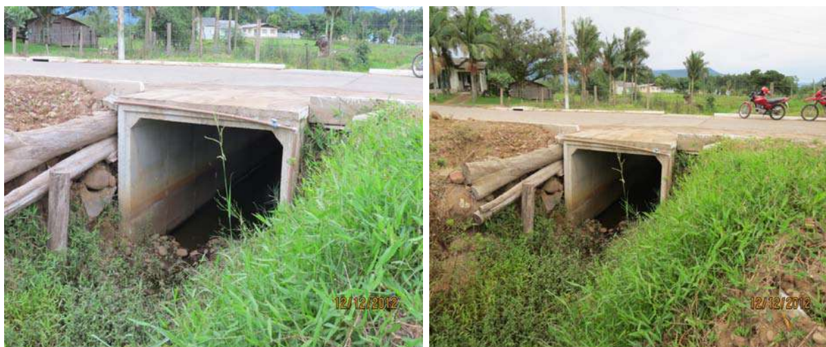
FOTO 09 e 10 – GALERIAS EM CONCRETO ARMADO (Foto: Diego Raupp)
