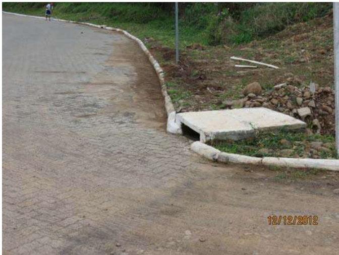
FOTO 11 - BOCA DE LOBO EXISTENTE (foto: Diego Raupp)
